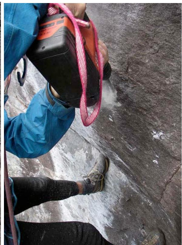
Sa ovom tehnikom počećemo bušenje rupe za glavu klina. Na ovaj način ćemo dobiti prav kanal koji je potrebno samo produbljivati. Prvo treba da napravimo malu rupu da bismo mogli pravilno pozicioniramo burgiju.
