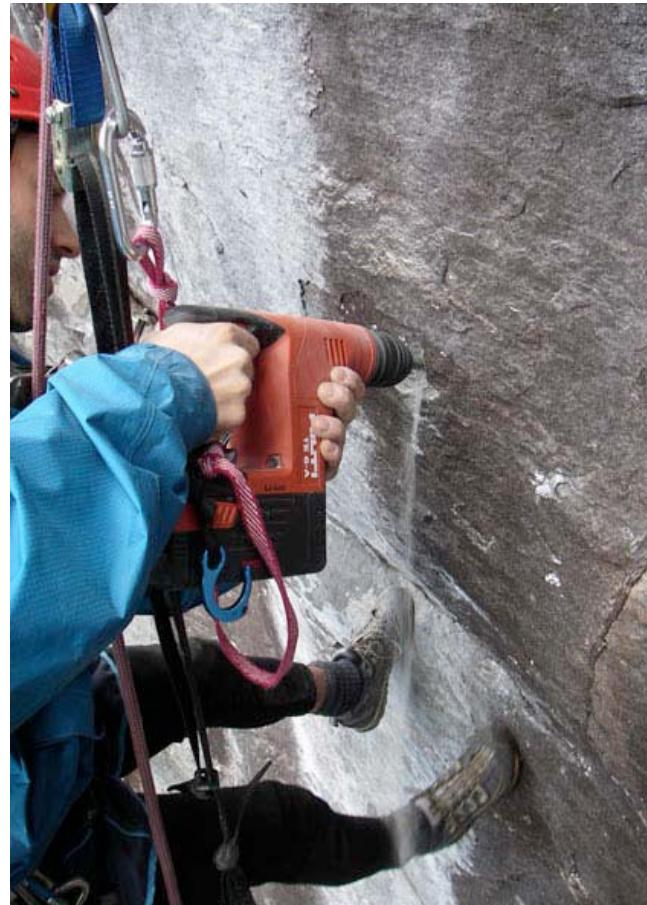
Za standardni klin (10x80mm) burgijom od 12mm dužine 16cm treba bušiti dok guma bušilice skoro ne dodirne stenu.
